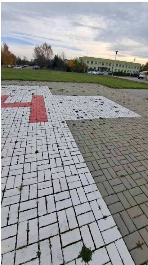
Istniejąca strefa TLOF z kostki betonowej
